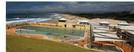
Port Kembla Pool
